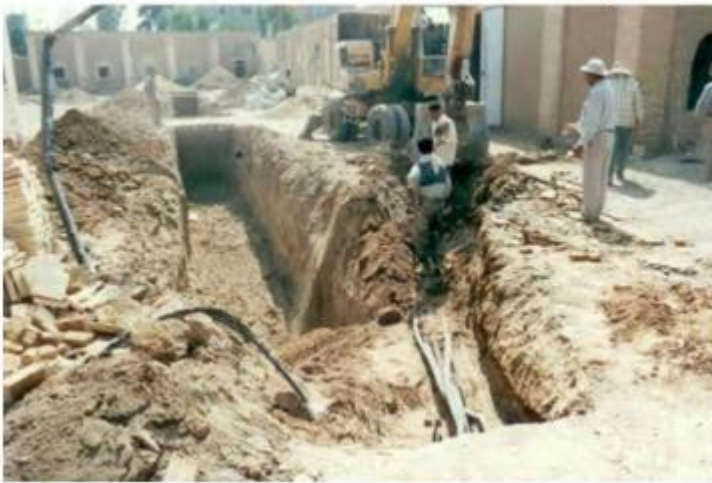
تصویر ۱۲- حفر کانال‌های آدم رو در مجموعه
