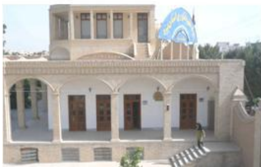
تصویر ۹- نمایی از ساختمان سردر مجموعه، قبل و بعد از بازسازی
