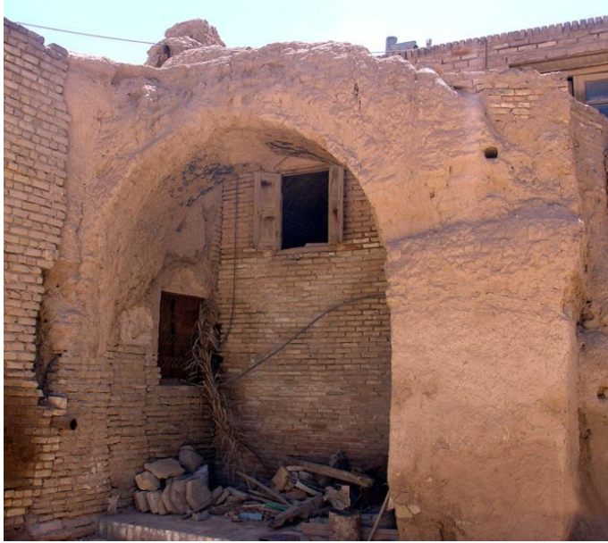
تصویر شماره ۲- طاق خشتی به جای مانده از مسجد عتیق (منبع: پرونده ثبت جهانی مسجد جامع - اداره کل میراث فرهنگی یزد)
