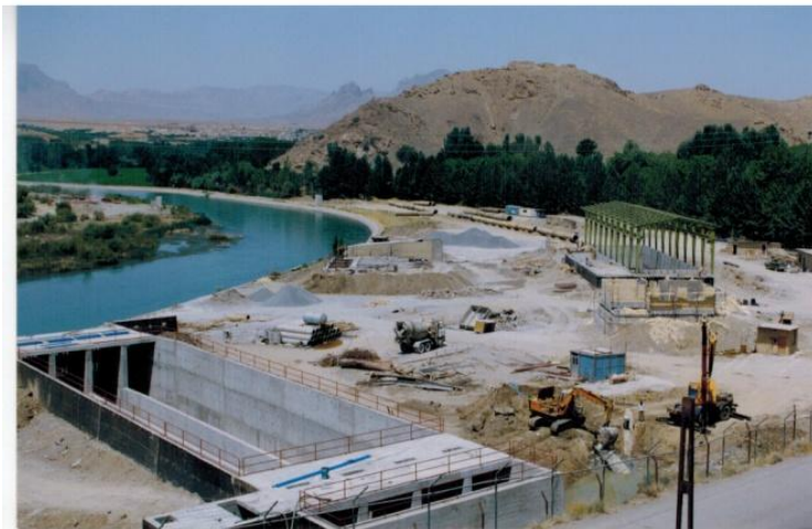
تصویر شماره ۷- احداث آبگیر خط انتقال آب- منبع: شرکت آب منطقه‌ای یزد
