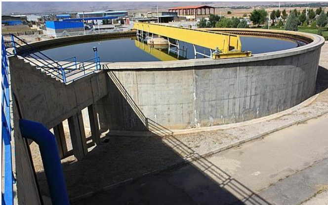
تصویر شماره‌ی ۱۰- مخازن آب تصفیه‌خانه- منبع: شرکت آب منطقه‌ای یزد
