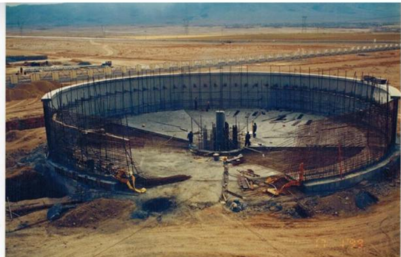
تصویر شماره‌ی ۶- احداث مخازن آب تصفیه‌خانه- منبع: شرکت آب منطقه‌ای یزد
